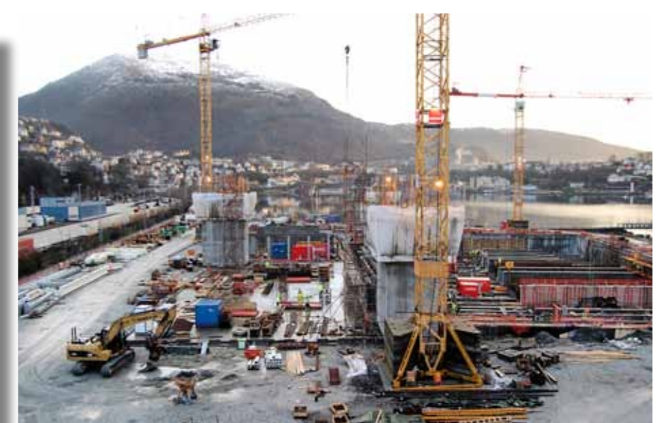
Arbeidet med å føre opp de fem trappetårnene konstruksjonen skal hvile på glideforskaling pågår for fullt på Nygårdstangen.
